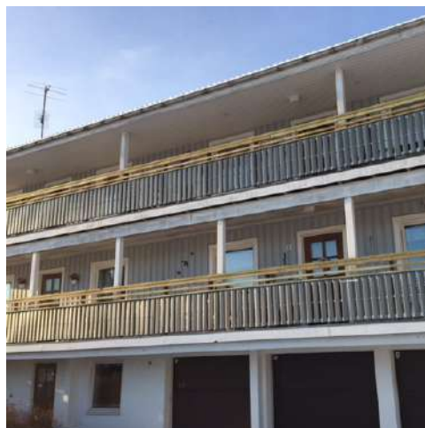
BILD 6 - GRÅ LOFTGÅNG PÅ BEFINTLIGA STOLPAR
