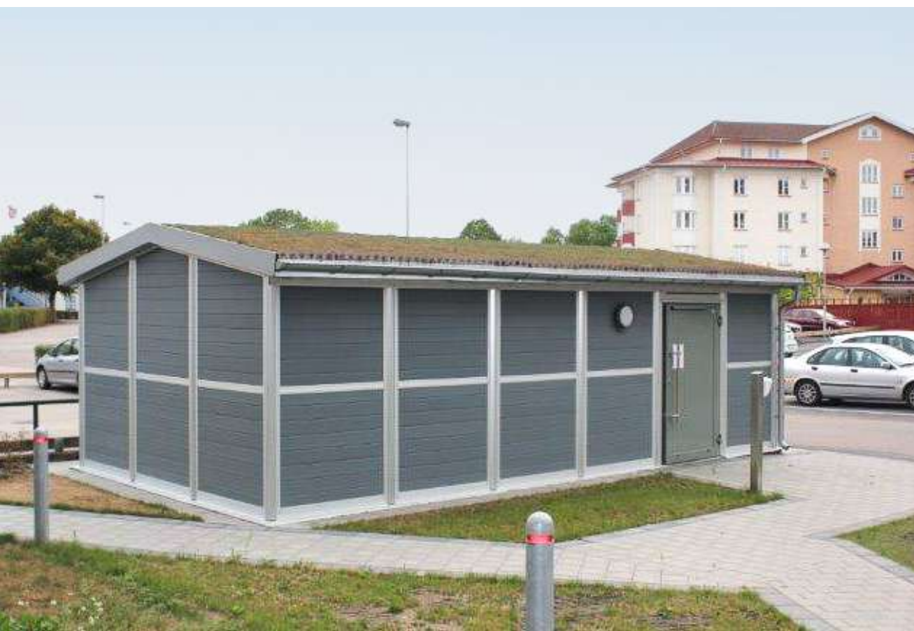
BILD 6 - GRÅTT SADELHUS MED SEDUMTAK
